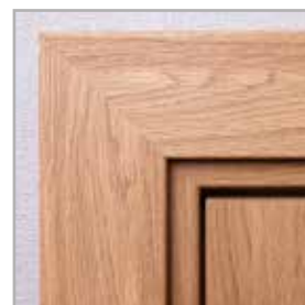
standardowe łączenie opasek pod kątem 45°
